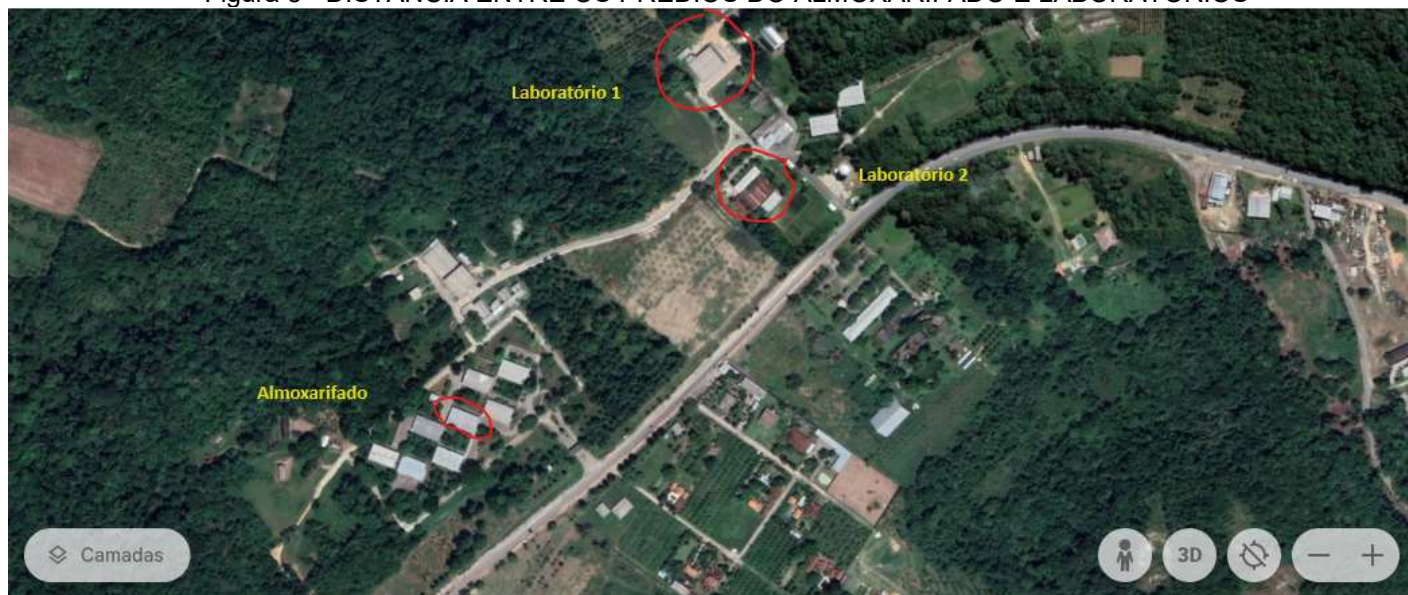
Figura 8 - DISTÂNCIA ENTRE OS PRÉDIOS DO ALMOXARIFADO E LABORATÓRIOS
